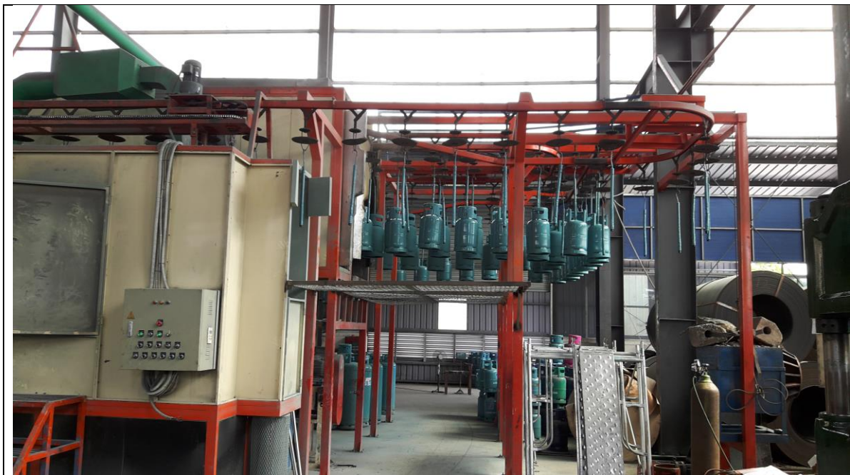
Công đoạn làm sạch, phun sơn bình GAS
